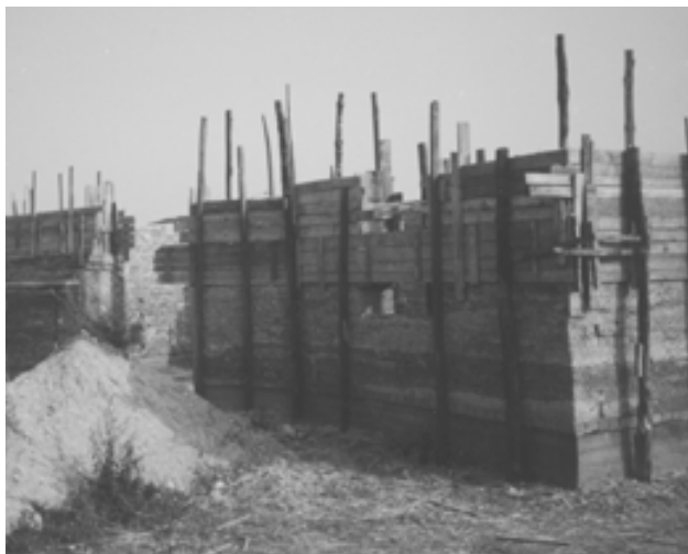
4. ábra Vertfalas módszerrel készülő épület
