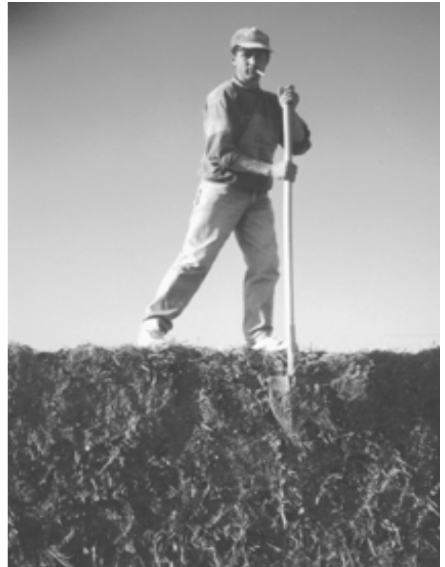
3. ábra Falsík kialakítása ásóval
