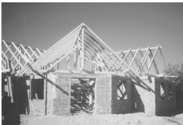
13. ábra Épülő vályogház
