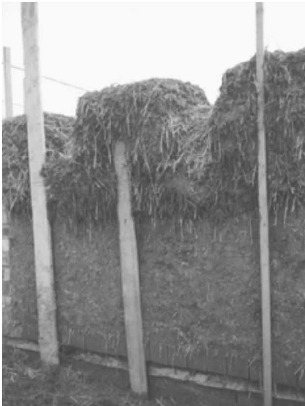
2. ábra Hagyományos módszerrel rakott fal
